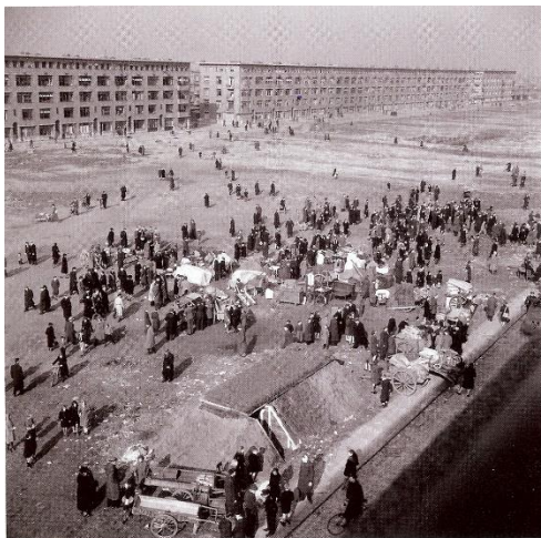
AFBEELDING 28: NOORDERHAVENKADE, MET PUIN GEDEMPT, APRIL 1945.
